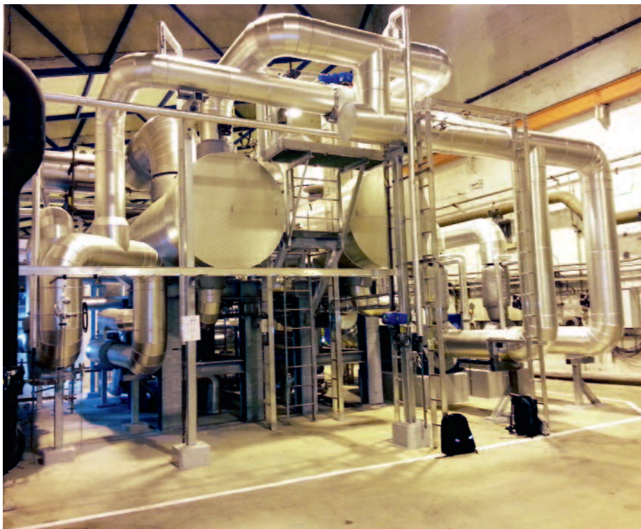
Fjernvarmevann varmes opp ved at damp suges inn til to varmevekslere som er installert like ved dumpetanken. Varmevekslerne er bygget på tilsvarende måte som kondensatorer for dampturbiner. Med denne konstruksjonen oppnås lavt trykkfall på dampsiden, og dermed høyest mulig turtemperatur på fjernvarmen.
