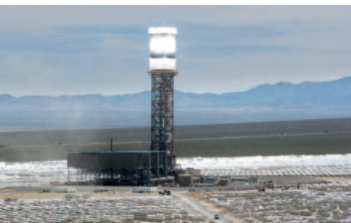
Dette er ett av i alt tre kraftverkstårn, som utgjør det nye solkraftverket i Ivanpah i California.
